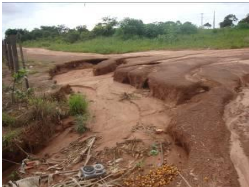
Figura 23: Araguaína: Rua no Setor Morada do Sol, terceira etapa.
