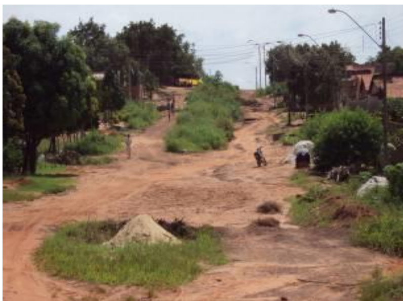
Figura 19: Araguaína: As cenas do quadro deteriorado da infraestrutura urbana se repetem também no Setor Universitário.
