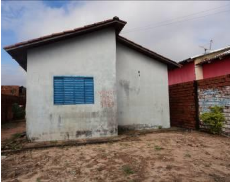
Figura 5: Modelo de moradia social do Residencial Jardim das Flores Fonte: VASCONCELOS FILHO/2013
