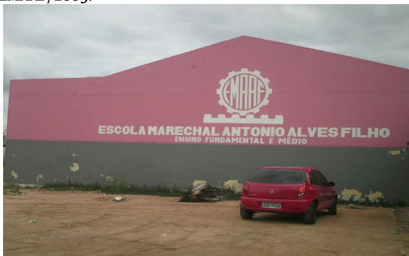
Foto 2 – Parte externa da Escola Marechal A Alves Filho - EMAAF/2009.
